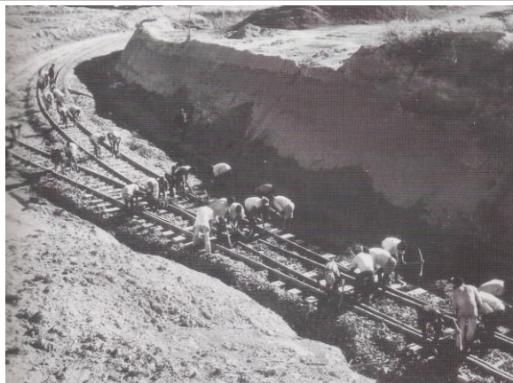
Operários trabalhando em novos ramais no caminho-de-ferro de Benguela
